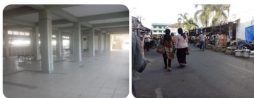
Gambar 2. Bangunan pasar yang tampak kosong (kiri) Pedagang yang berjualan di jalan (kanan)
